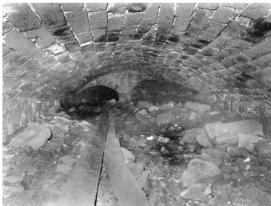
Téměř zcela zavalená rozdvojená komora u konce stoky
