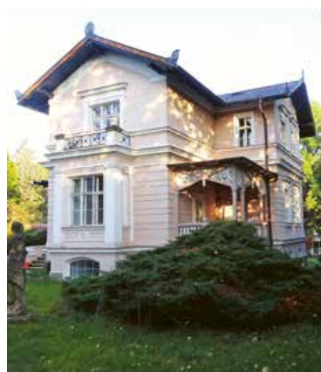
Vila čp. 98 před necitlivou přestavbou (2019)
