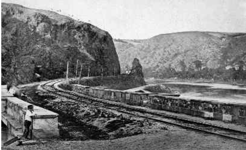
Dobová fotografie jednokolejné trati Praha-Kralupy, úsek mezi Sedlcem a Roztokami
