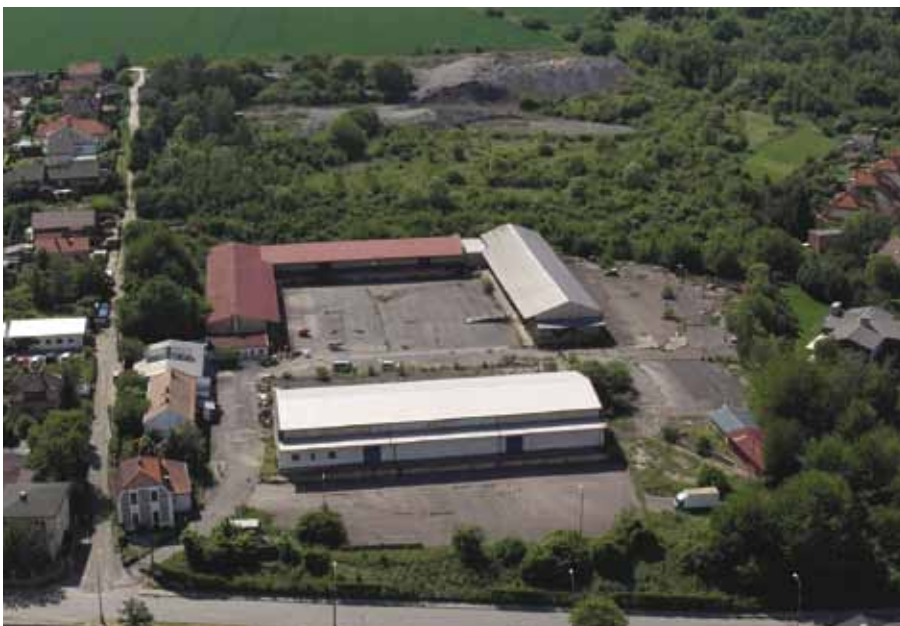
Současný stav areálu
