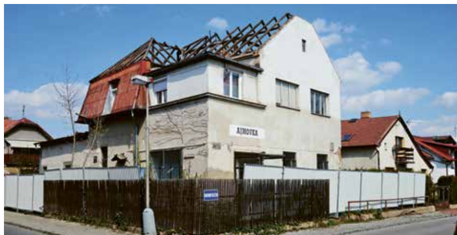
Objekt Ajmovky na začátku demolicie, v dubnu 2020
