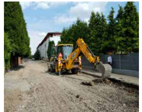
Rekonstrukce Braunerovy ulice.
