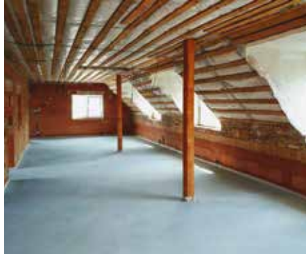
Výstavba nové MŠ za úřadem
