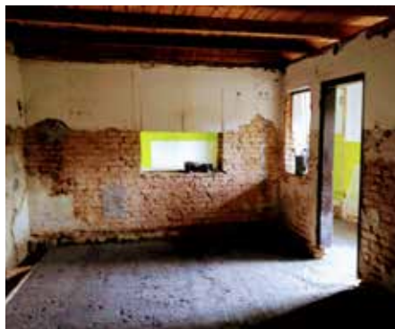
Rekonstrukce kotelny v MŠ Spěšného
